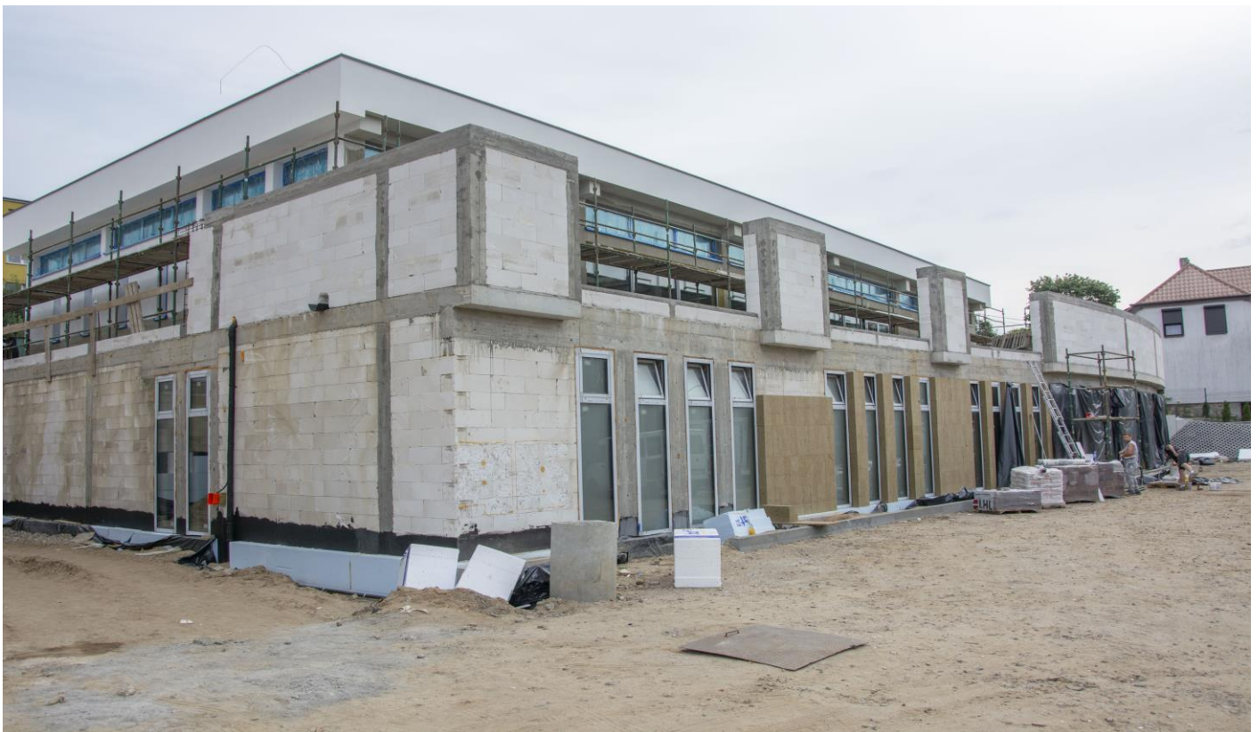
Fot. 1. Budowa sali gimnastycznej z zapleczem rehabilitacyjnym SOSW w Bytowie
