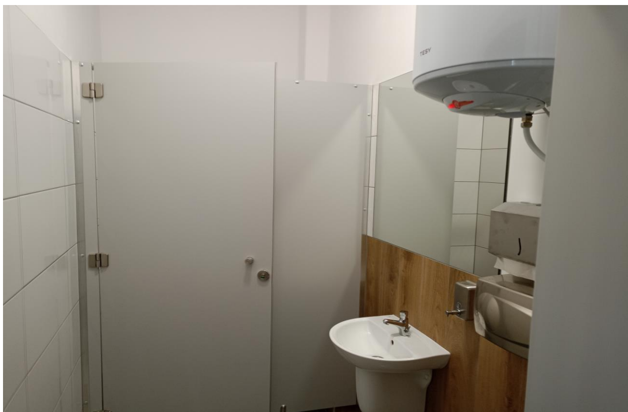
Fot. 3. Wyremontowana toaleta w budynku szkolnym SOSW w Bytowie
