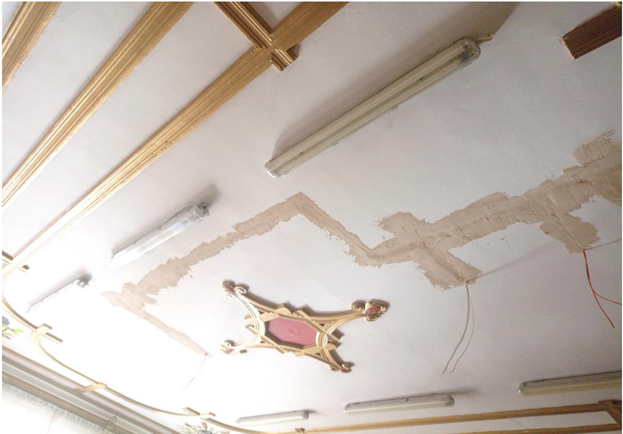
Fot. 4. Montaż instalacji p-poż. w budynku szkolnym SOSW w Tursku
