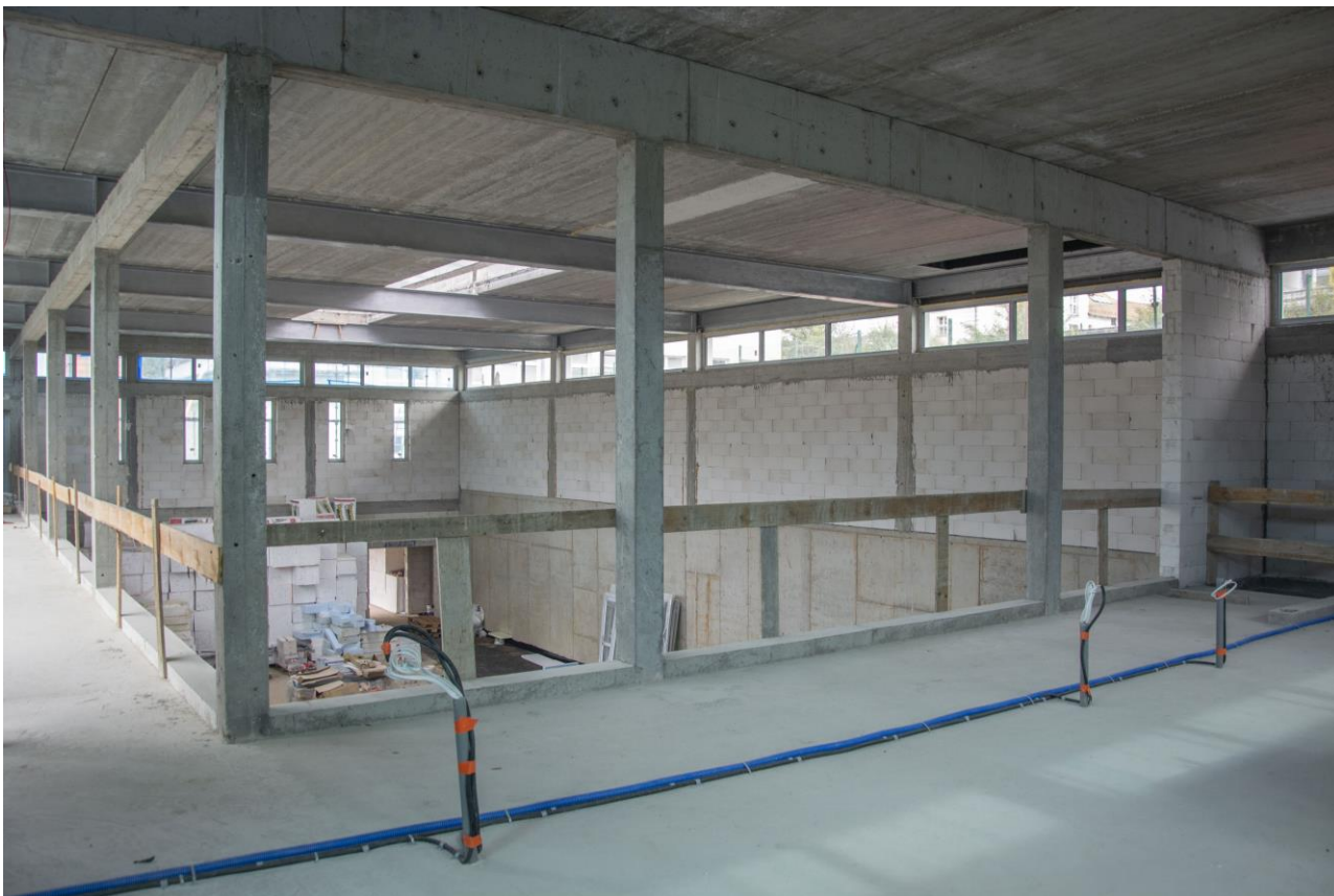
Fot. 2. Budowa sali gimnastycznej z zapleczem rehabilitacyjnym SOSW w Bytowie
